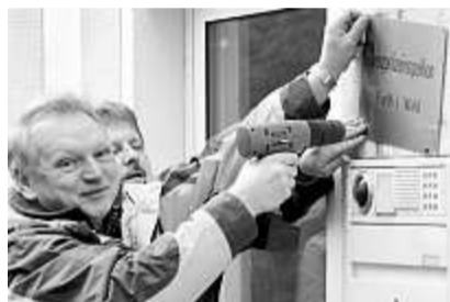
Erwin Maler, der dienstälteste Beamte der Grenzpolizei-Inspektion Furth im Wald, durfte eine der Schrauben entfernen und das Türschild abbauen.
