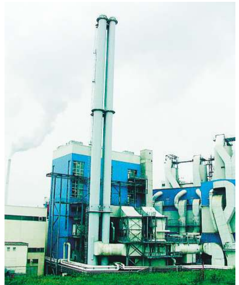
Die Stadt argumentiert: Lieber eine maximale Auslastung des Müllkraftwerks mit seinen strengen Grenzwerten (unser Bild) – als ein neues Kraftwerk der Nabaltec mit weniger strengen Auflagen. Foto: Archiv
